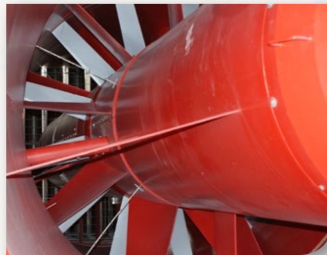
Ehrentalerbergtunnel - Klagenfurt, Austria
