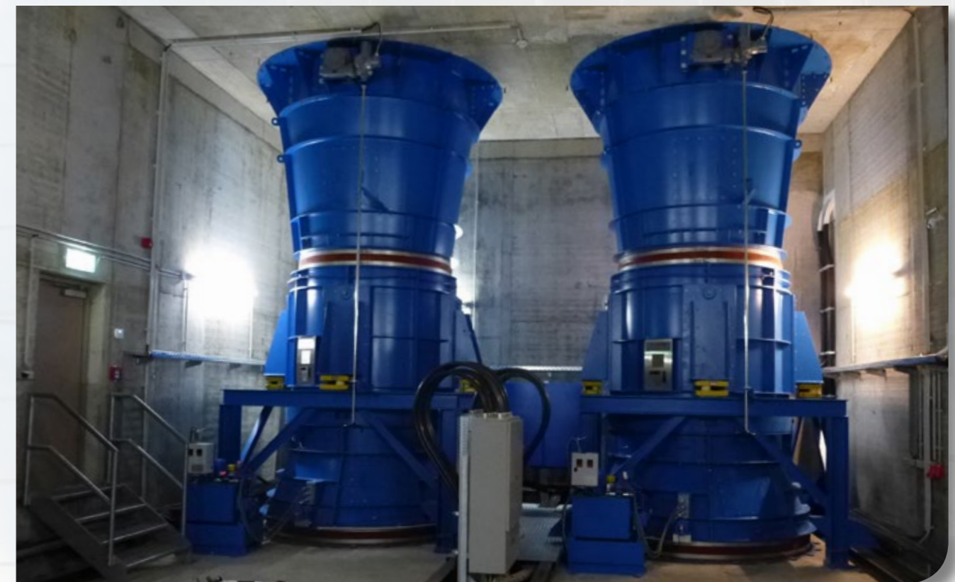
Tunnel Gernsbach - Gernsbach, Germany
