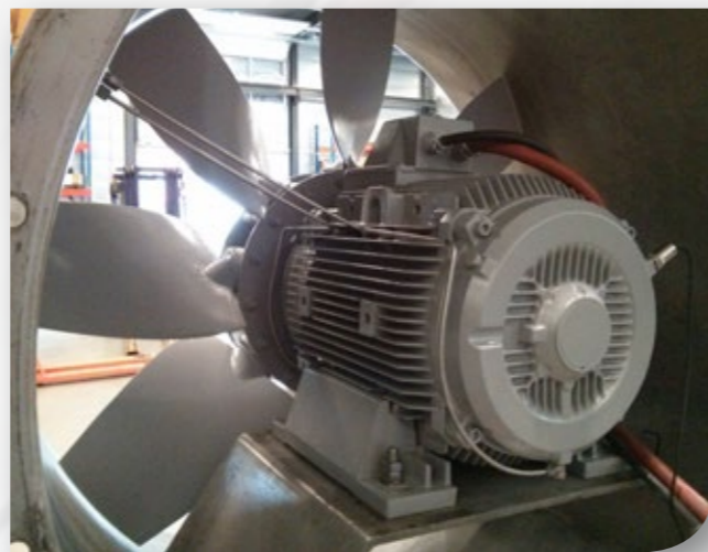
Assembly overhauled jet fan
