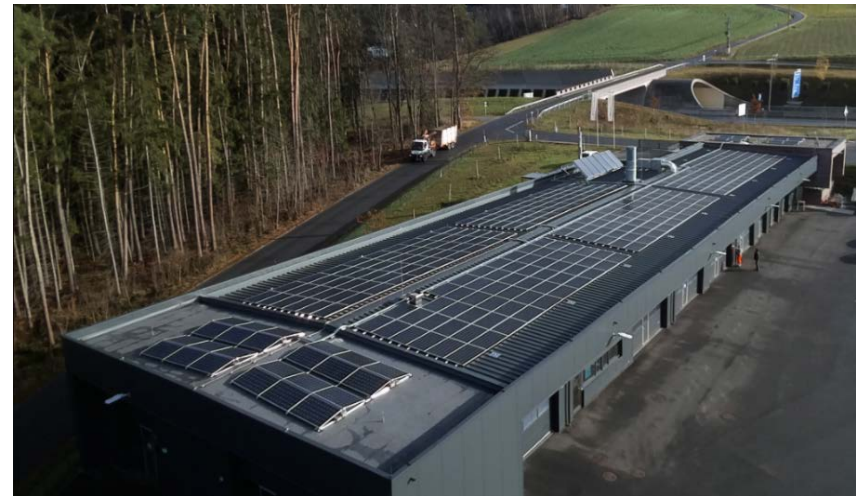
S10 Tunnel Manzenreit / 120kWp
