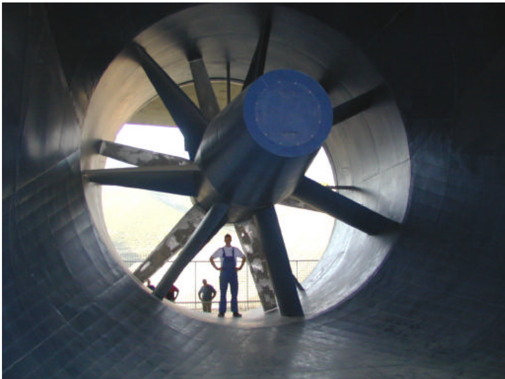
Fig. 5 ST2 Supply fan
