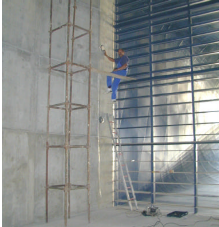
Fig. 8 Damper for ST2 fan
