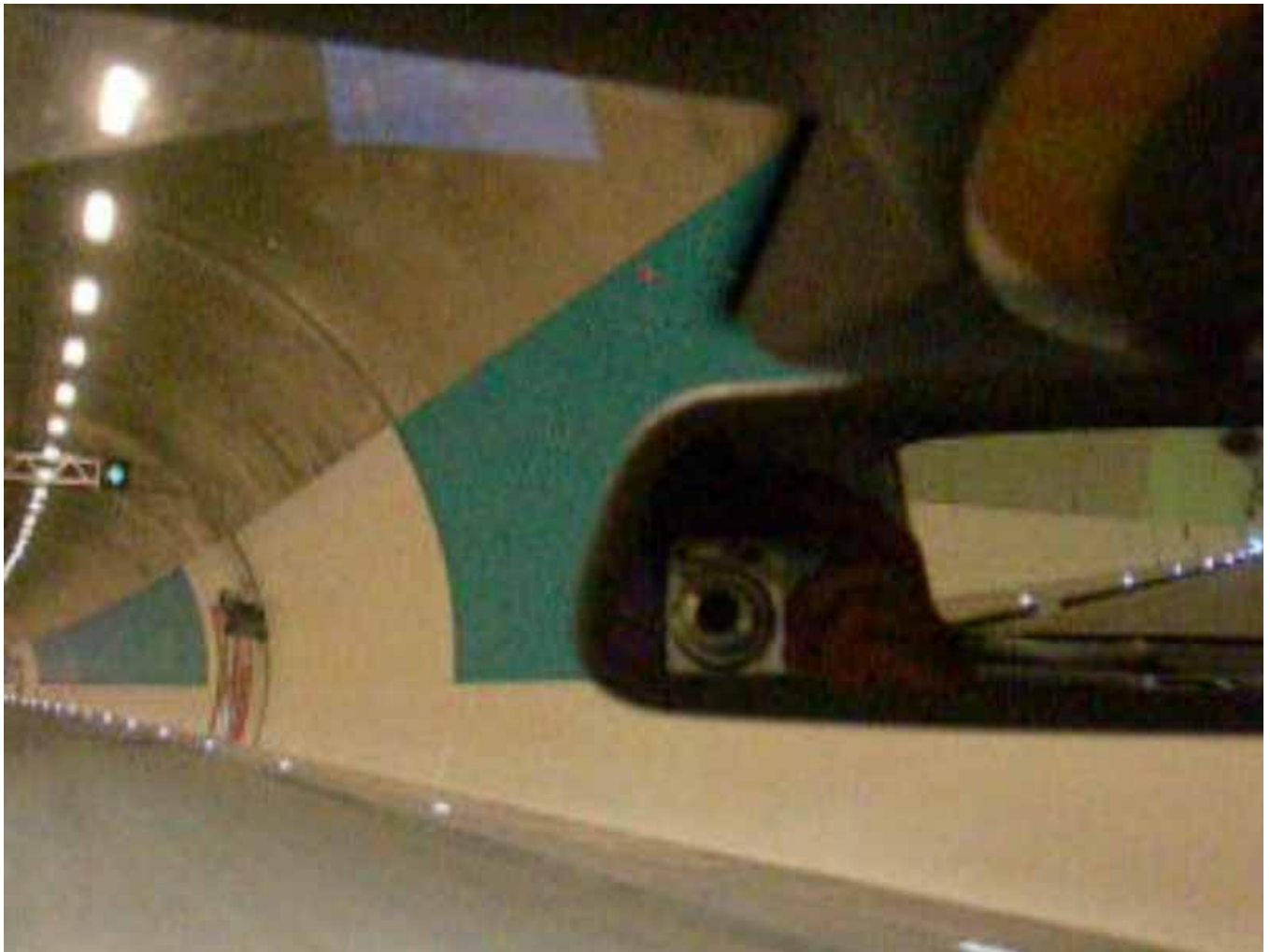
Figure 6: Tunnel Gousselerbiertunnel, Luxembourg
